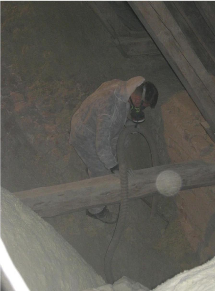
Bei dem Entdämmungsarbeiten auf dem Dachboden benutzen die beiden Mitarbeiter jetzt schon eine ausgewachsene Gasmasken um sich zu schützen. "Besser ist es!" Niemand weiß, was sich alles in diesem alten Dämmstoff befindet. Jedenfalls hat das Material auch Glasanteile. Mir stockt der Atem, wenn ich nur kurz dort oben bin. Darum bin ich froh, dass die Firma jetzt solche Sicherheitsmaßnahmen getroffen hat.
