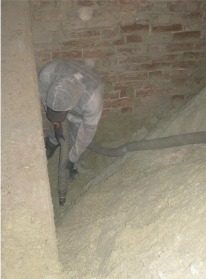
Dann wird das Isolationmaterial mit einem Rohrleitungssystem nach draußen befördert, in Säcke verfüllt und an eine Entsorgungsfirma übergeben.
