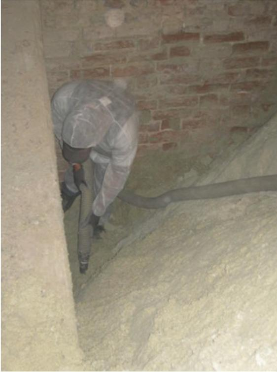
Fast wie mit einem riesigen Staubsauger saugten die Mitarbeiter des Zimmereibetriebes die Isolation ab.
