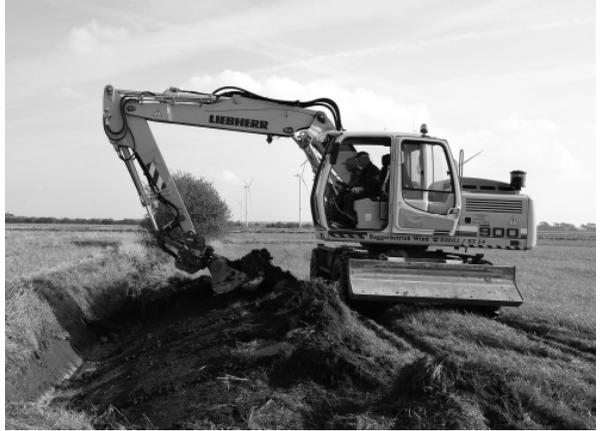
Umsetzung. Der Bagger hebt einen Graben aus. Der Aushub wird zu einem Wall aufgeworfen und spater bepflanzt. Dann haben wir bald zwei neue Knicks! Sie werden in ein sog. „Knickkonto“ eingebracht.
